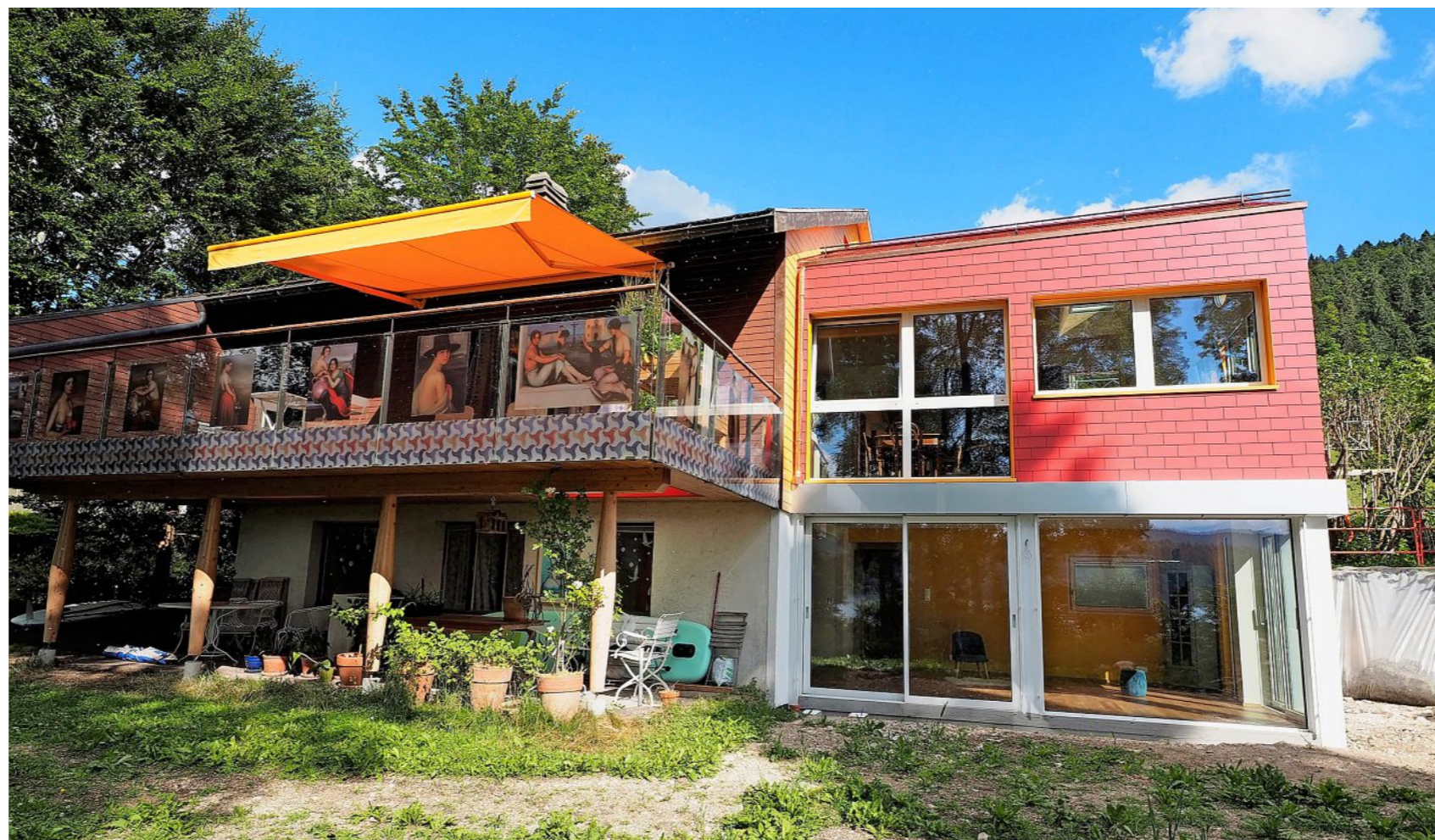
La maison en cours de rénovation de l'architecte Claude Chanel: à gauche, la balustrade comporte des sérigraphies. A droite, le vitrage a un coefficient de transparence et de réflexion réduit. Effet quasi imperceptible pour les humains. Mais les oiseaux, eux, voient l'obstacle. DR
